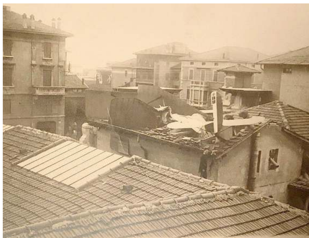
Due scatti. Il Fiat Br1 del XIII Stormo bombardamento del pilota Rolando Fratelli e del motorista Alfredo Sulta sul tetto della Moretto Film di via Solferino dopo lo schianto // FOTO ARCHIVIO CENTRO STUDI RSI - SALÒ FONDO M.V.
