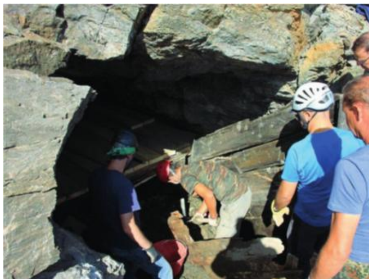
I lavori: Per il recupero della grotta è stato necessario sciogliere il ghiaccio con idropultrici con acqua tiepida
