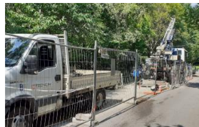
Il cantiere per i carotaggi del suolo dove passerà la galleria
