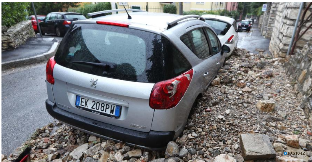
Un muretto in via Santelle non ha resistito alla furia del vento e della pioggia: è parzialmente crollato danneggiando le auto in sosta lungo la strada che da Borgo Wührer porta alla Maddalena
