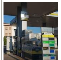
Distributori fermi per lavori
