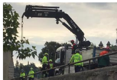
Nell'operazione di messa in sicurezza è stata utilizzata anche una gru
