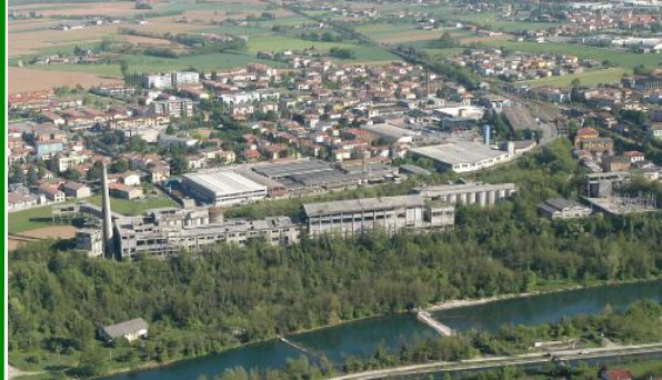
Una suggestiva immagine dall'alto dell'ex Italcementi che confina con il centro abitato
