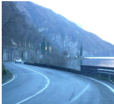
Il tratto di lungolago che sarà interessato dal nuovo cantiere
