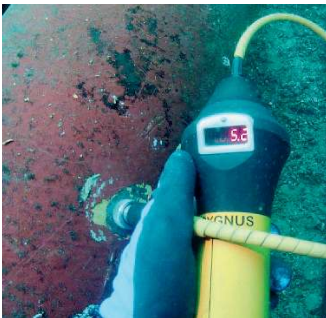
La verifica. Il monitoraggio di un anno fa sulla condotta sublacuale
