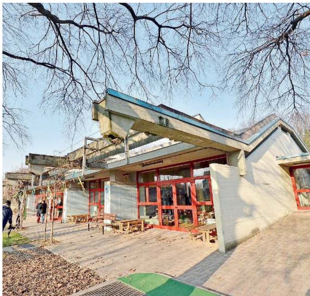
Via Panigada. L'ingresso della scuola materna Fiumicello di via Panigada
