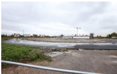
Lavori sull'area che ospiterà la nuova pista di atletica
