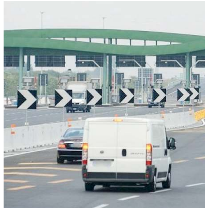
Brebemi. Il casello di Chiari est dell'autostrada A35
