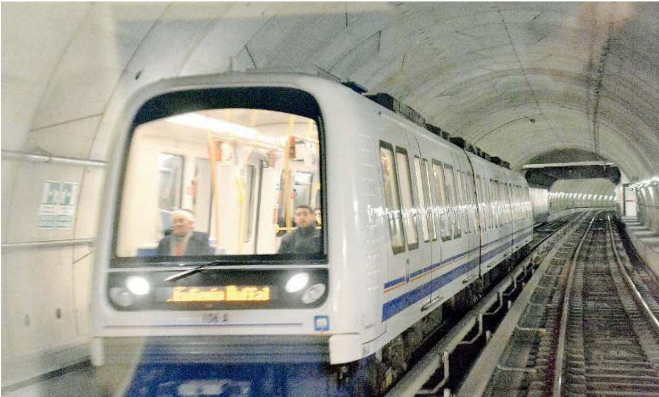
Metropolitana. Inaugurata il 2 marzo 2013, l'opera ha trasportato oltre 110 milioni di passeggeri, facendo crescere gli utenti del Tpl del 37%
