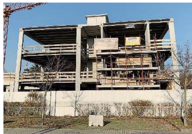
In via Trivellini. Lavori in corso per la nuova sede del Dormitorio
