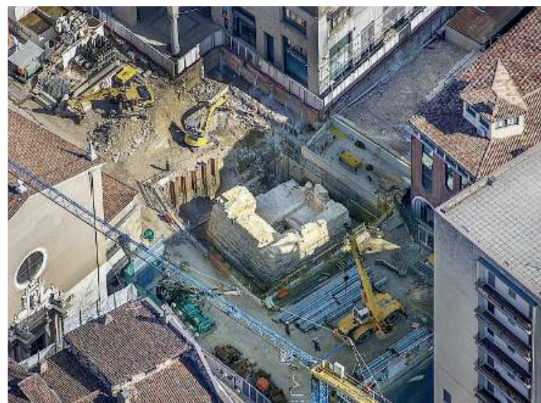
In piazza Vittoria. L'avvio della costruzione della torre
