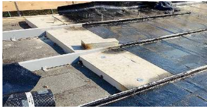
Cantieri. I lavori sul tetto
