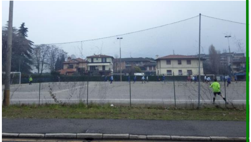
Il campo sportivo di San Bartolomeo, che da tempo attende un intervento di riqualificazione. Ora il Comune ha approvato il progetto
