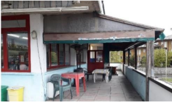
Al piano superiore, dove ci sono bar e terrazza, una nuova pavimentazione eviterà le infiltrazioni
