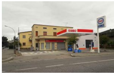
Nel terreno sotto il distributore di via Mantova ci sono idrocarburi
