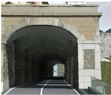
Così apparirà l'ingresso Sud della galleria austriaca di Edolo
