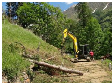
Lavori di bonifica verso le Case di Viso
