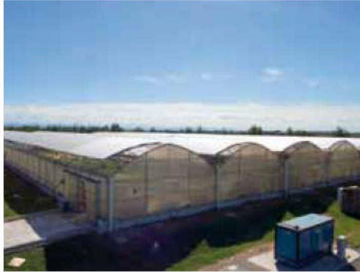
Serra riscaldata da impianto a biogas
